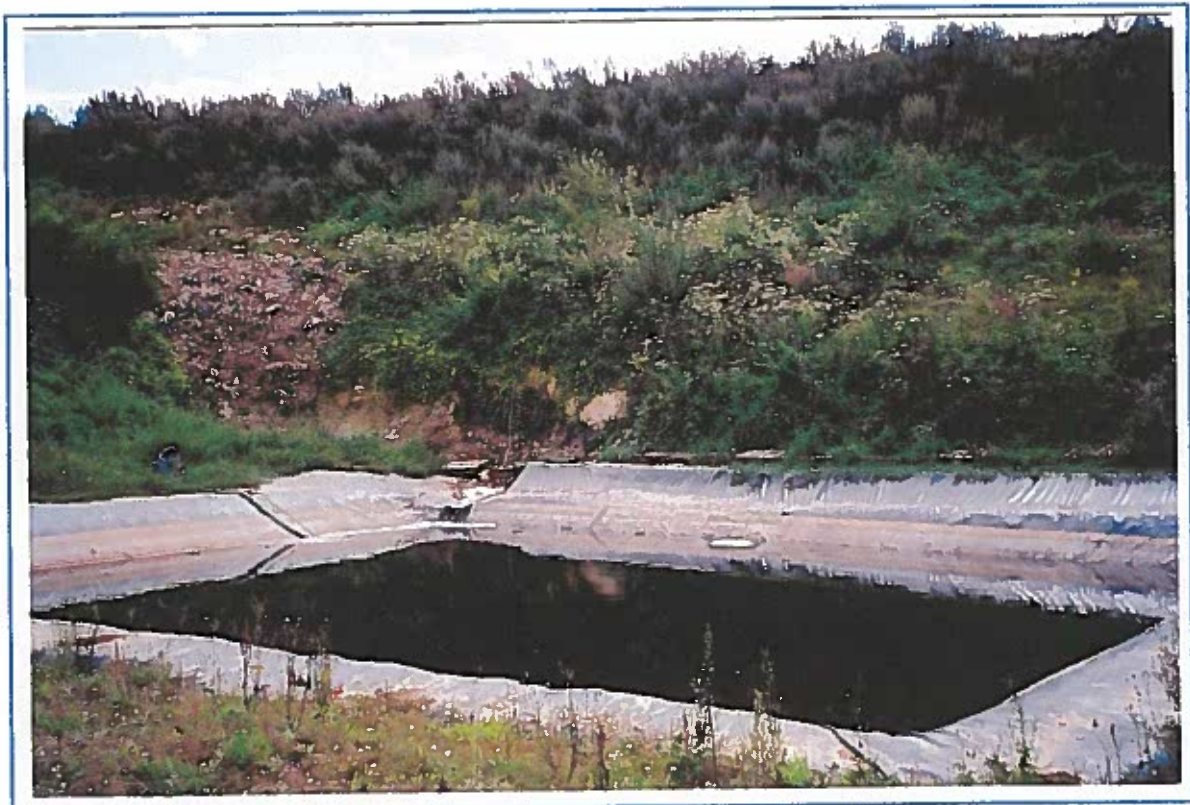
Photo n° 3 : Bassin de collecte des eaux pluviales et du lixiviat de décharge
